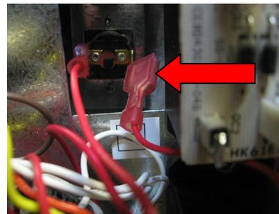
11- Connecter un cavalier entre la connexion libre du thermodisque et la masse
