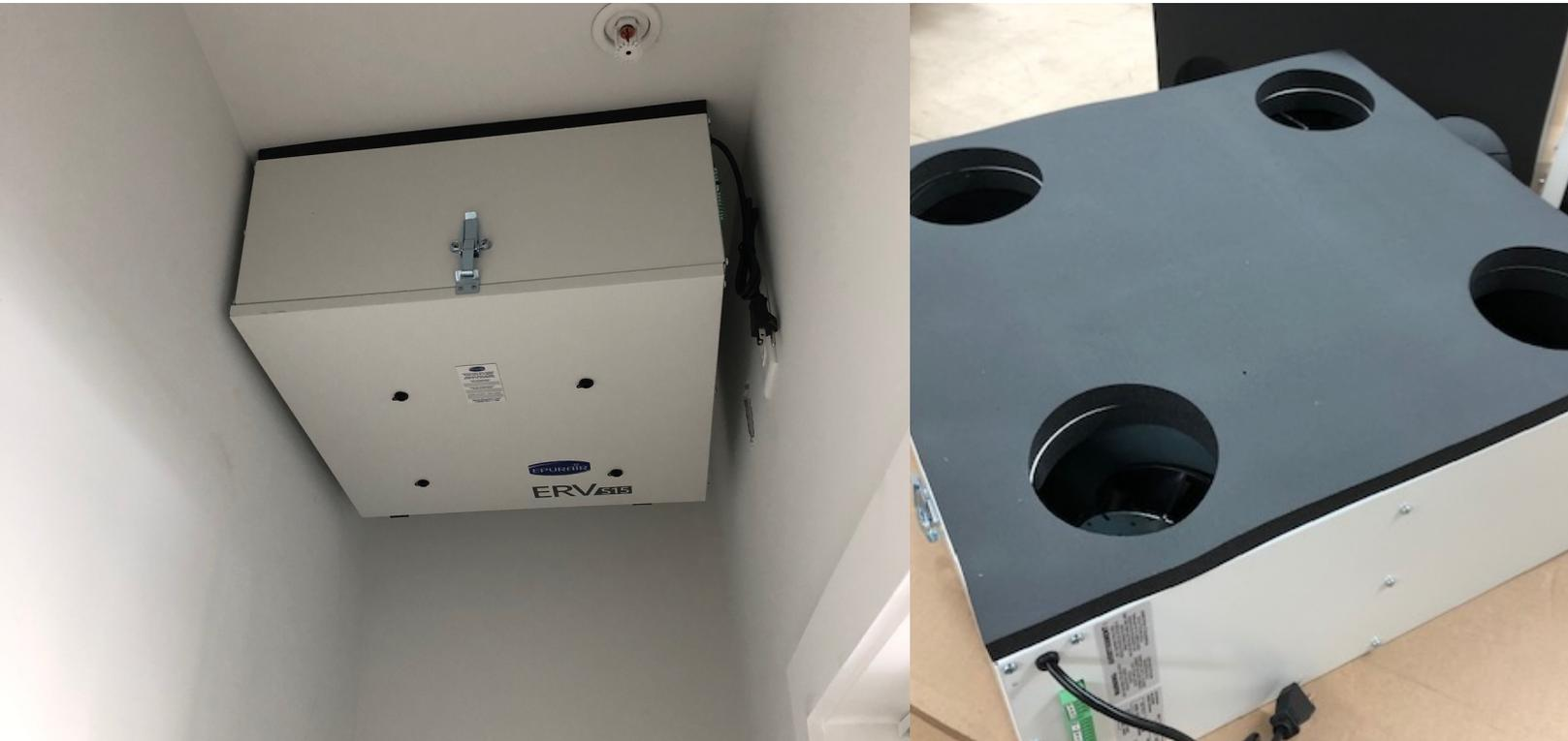
Les plaques de montage en acier SA-P5R permettent de fixer directement au plafond les modèles avec sorties au dos équipés de mousse (Foam Top Port) sans utiliser de conduits flexibles.
