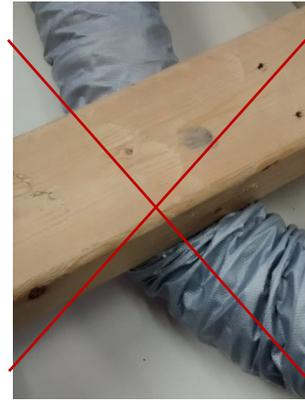
Figure 9: Ne pas écraser le conduit flexible
