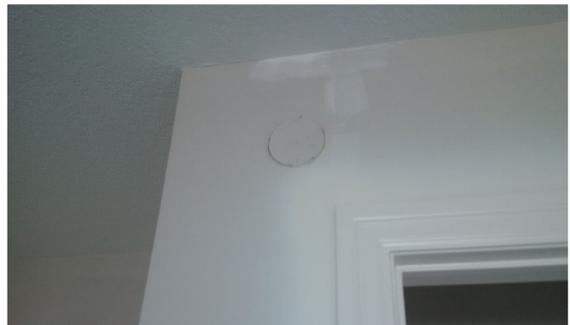
Figure 23: Installer le gypse et finir le mur
