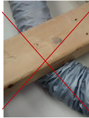
Figure 9: Ne pas écraser le conduit flexible
