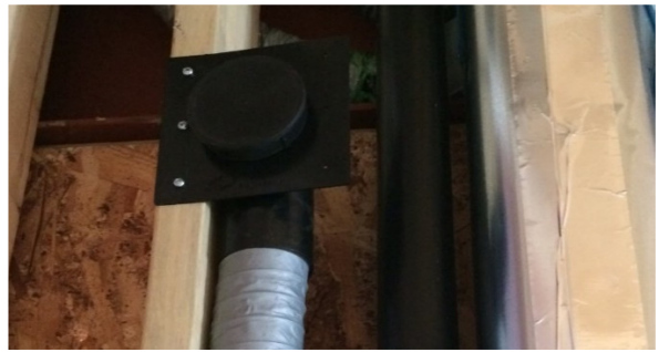
Figure 22: Fixer le collet sur le montant du mur
