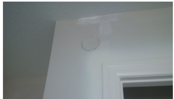
Figure 23: Installer le gypse et finir le mur
