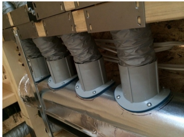
Figure 21: Visser la selle sur le tronc
