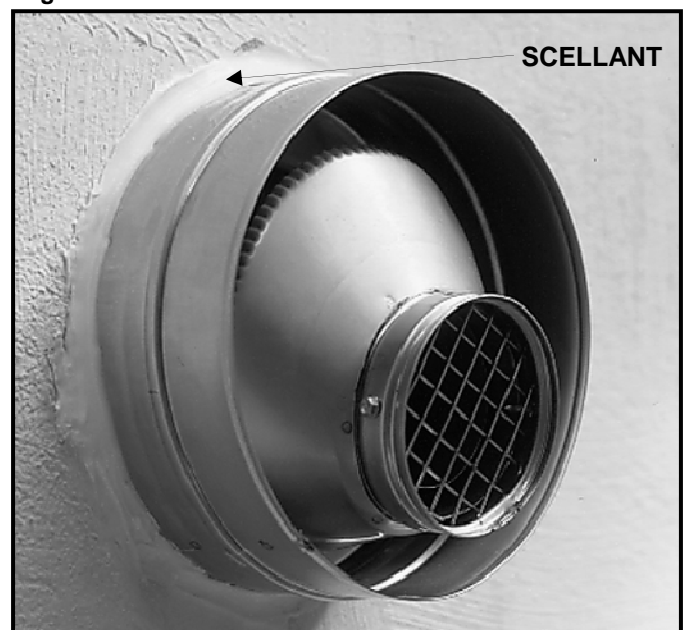
Figure 6 : Scellant autour du stabilisateur de l'évacuateur
