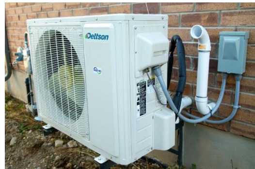
Alizé, l'unité de climatisation extérieure de type thermopompe de Dettson, qui permet le Right-Sized System. (Mike Hensen/The London Free Press/QMI Agency)
